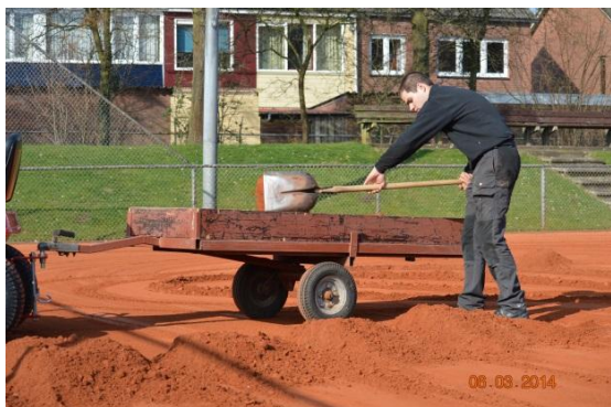
Afbeelding: aanhangwagen voor afvoeren vervuilde gravel
