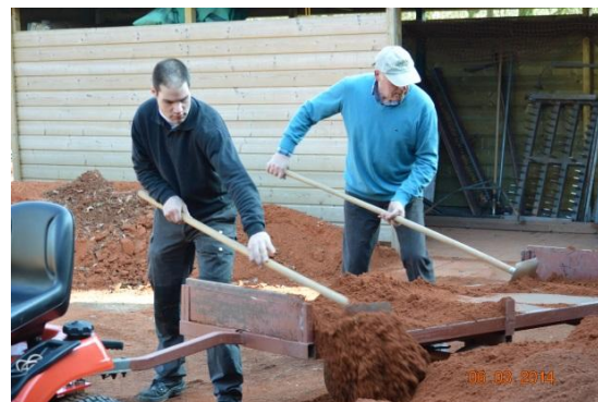
Afbeelding: aanhangwagen voor afvoeren vervuilde gravel
