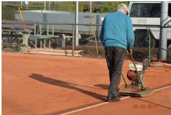
Afbeelding: natrillen met lichte trilplaat
