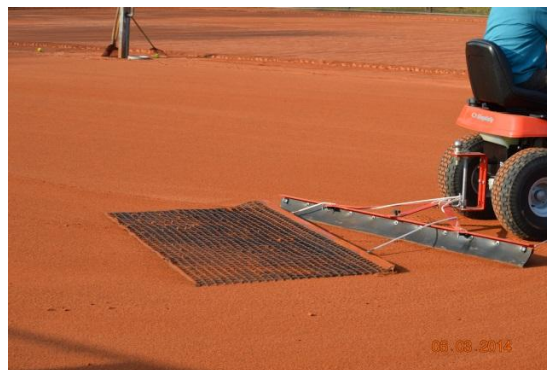
Afbeelding: rubberrei getrokken + sleepnet
